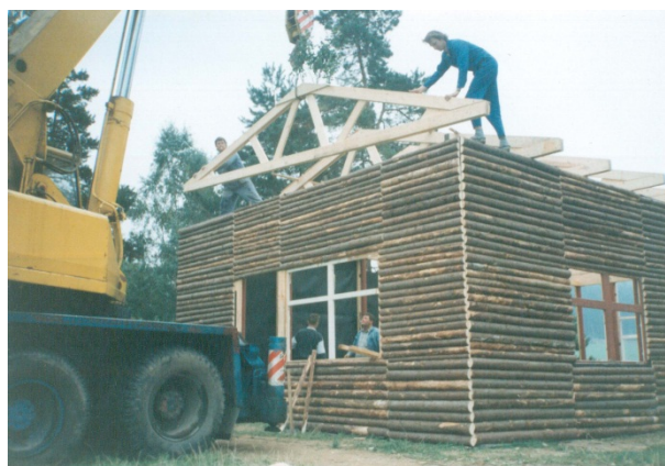
Obr. 25 Budování srubu, rok 1994
